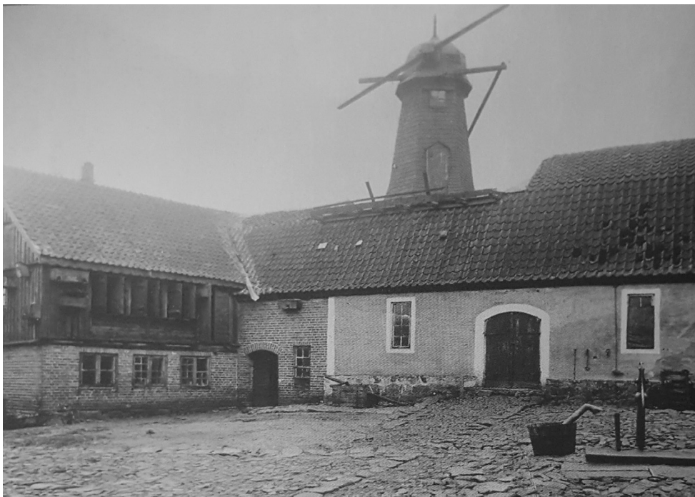
Was jetzt Parkplatz ist, sah während der Glanzzeit der "Strömska" Gerberei wie oben aus. Foto: Aus dem Archiv des Österlens Museums
